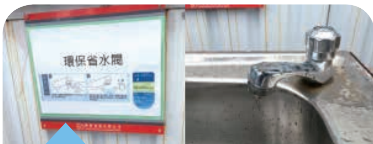
工地安裝節水器
