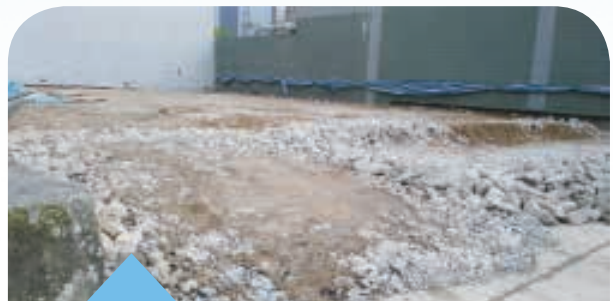
重用混凝土作填土用途
