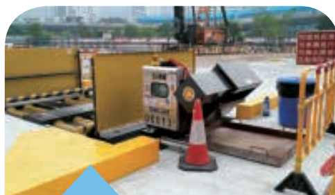
車輪清洗設施
