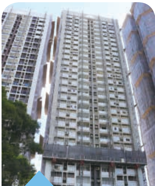
維修工程項目以塔式工作平台代替竹棚
